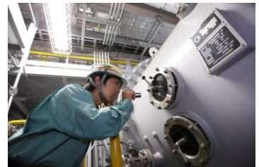
火力発電所点検の様子
